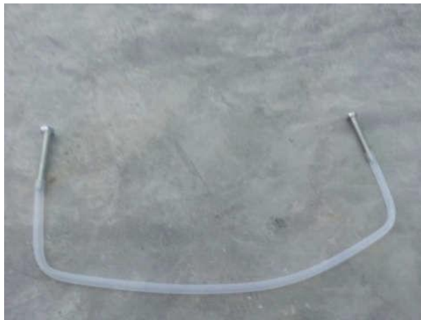
图 8.9 单元软管损坏示例
